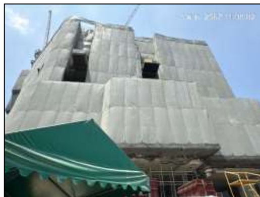
ภาพที่ 11 ติดตั้ง Mesh Sheet
