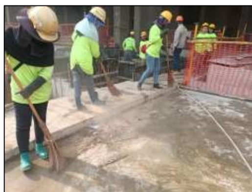
ภาพที่ 12 คนงานฉีดพรมน้ำและกวาดทำความสะอาดบริเวณพื้นที่ก่อสร้าง
