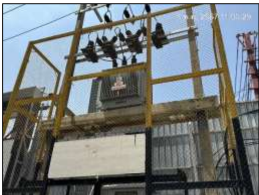
ภาพที่ 43 หม้อแปลงไฟฟ้า
